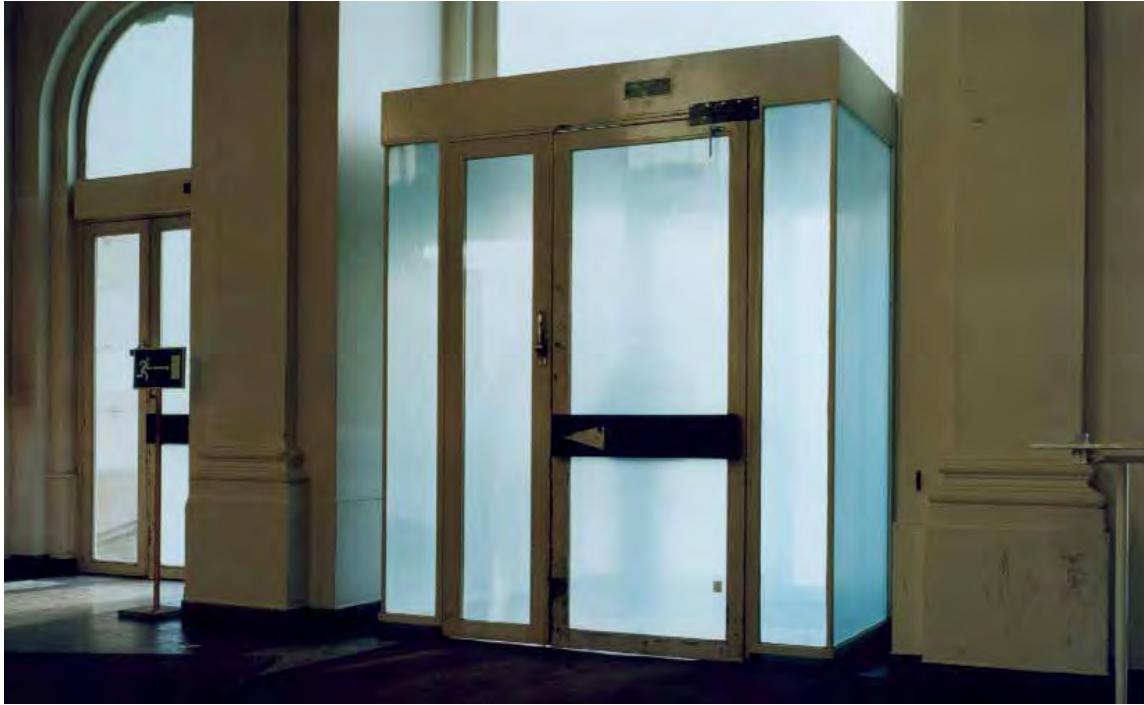
wärmestube, Eingangsbereich, Buttermilch auf Glas.
